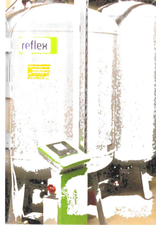
Behälter für die Druckhaltung und Entgasung sowie die automatische Nachspeisung der Solarthermieanlage.
