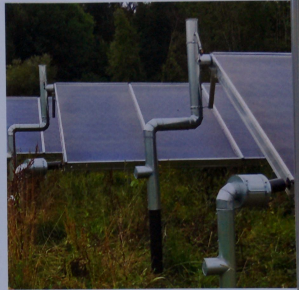
Das über tausend Quadratmeter große Solarfeld ist aus circa zwei Quadratmeter großen Kollektoren aufgebaut. Jeweils fünf Kollektoren bilden ein Freilandgestell. Fotos: Dany
