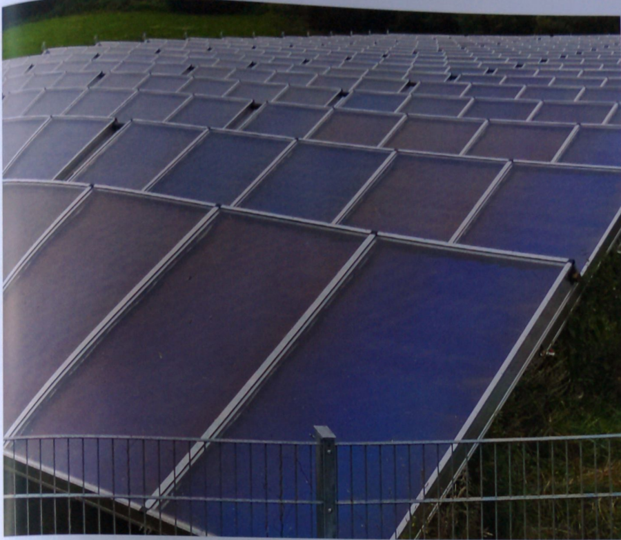
Das über tausend Quadratmeter große Solarfeld ist aus circa zwei Quadratmeter großen Kollektoren aufgebaut. Jeweils fünf Kollektoren bilden ein Freilandgestell. Fotos: Dany
